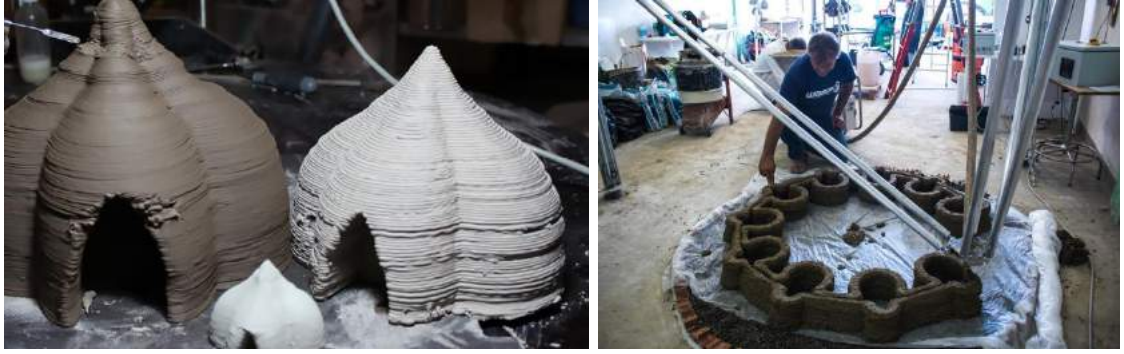
Resim 3.35. 4 metre uzunluğundaki seramik evlerin prototipleri ve çalışma süreci
