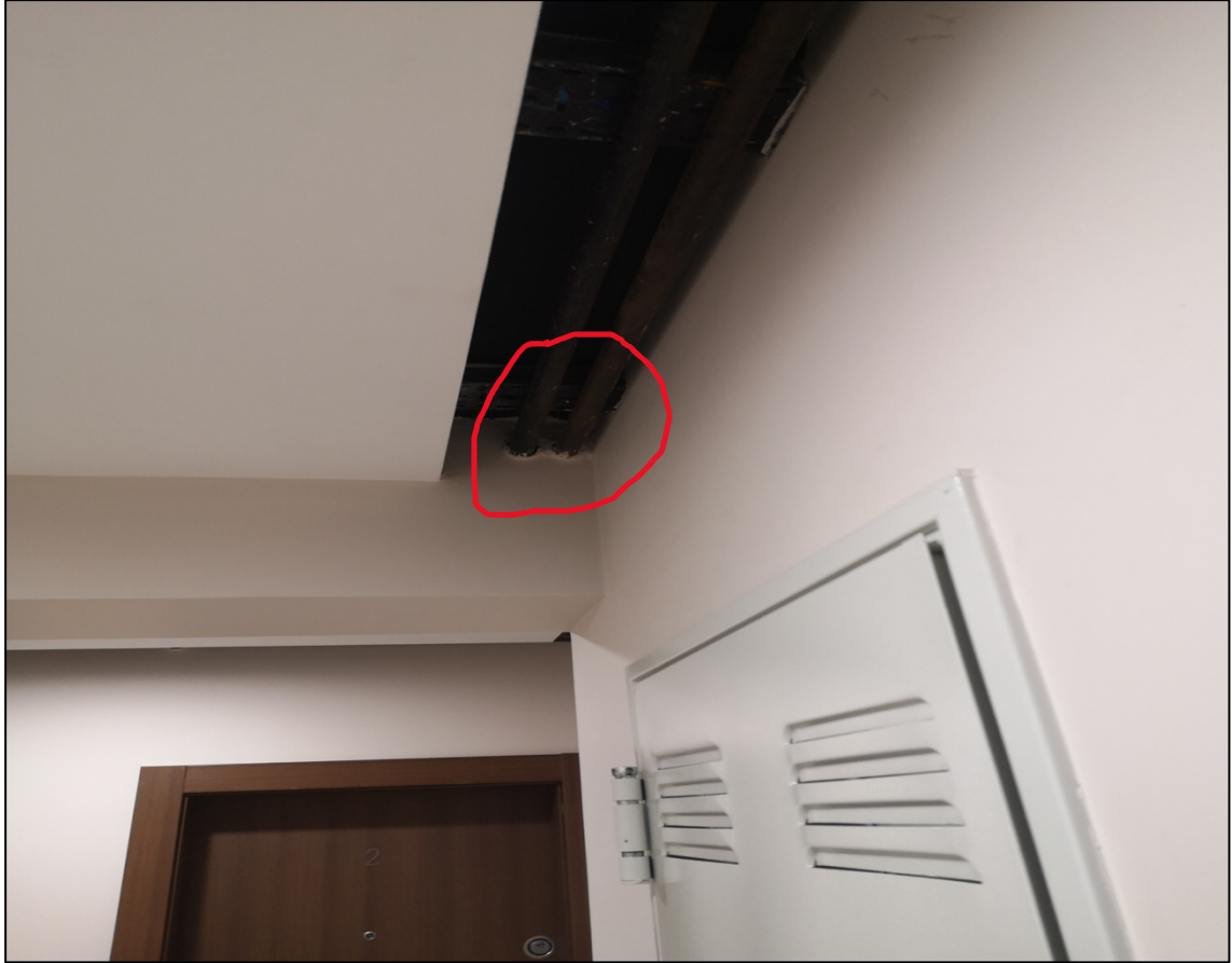
Resim 10. Doğalgaz Borularının Kirişler ve Kolonlar Delinerek Döşenmesi Resmi
