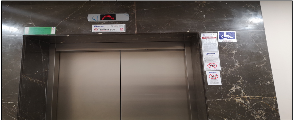
Resim 23. Proje Alanında Yapılan Engelli Asansörleri
