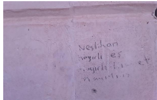
Fotoğraf-271: Benetis Sitra (İbleliye) Türbesi Duvarı
