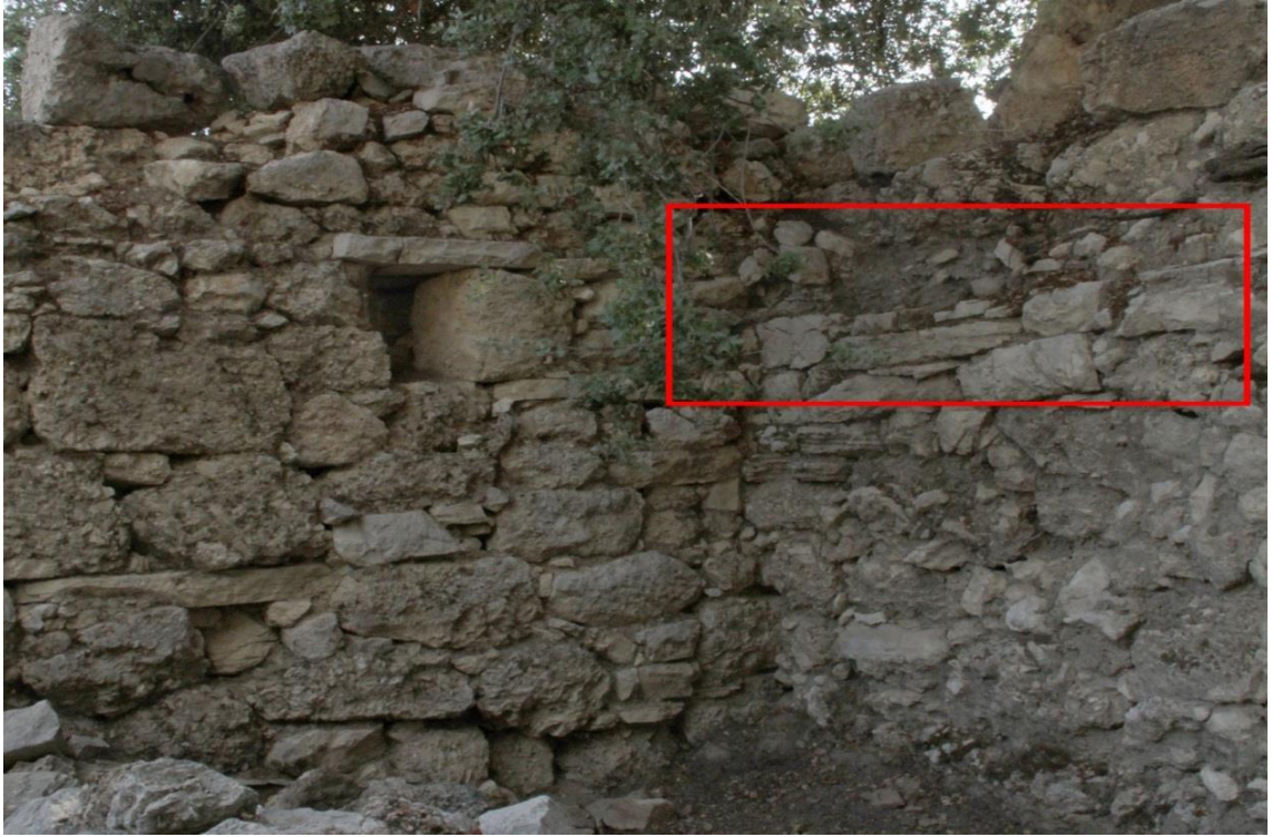
B-7 no.'lu mekânın batı duvarında bulunan duvar yatağı
