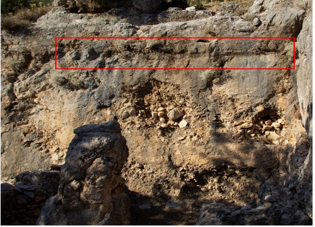
6 no.'lu mekânin kuzey duvarı
