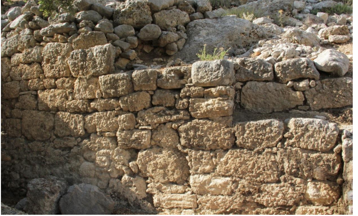
A-9 no.'lu mekânin kuzey duvarı
