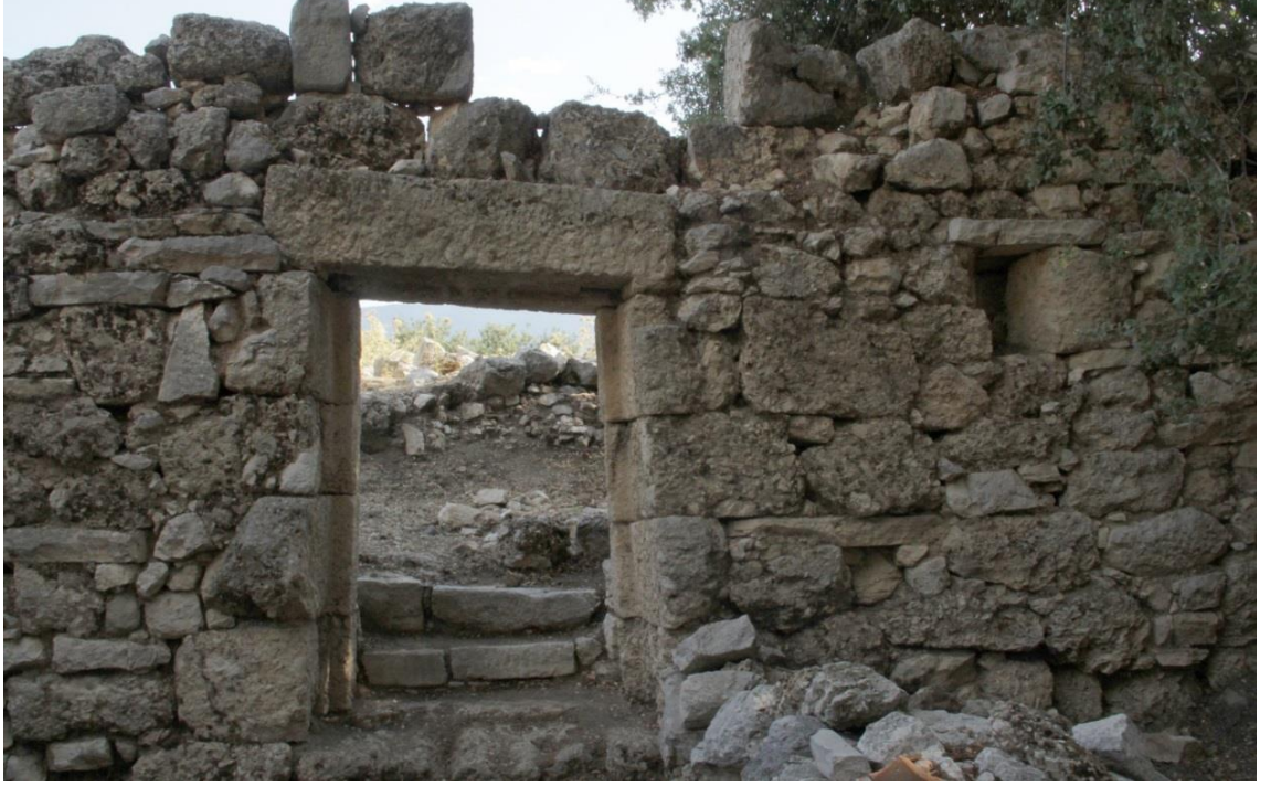
A-7 no.'lu mekânın güney duvarı
