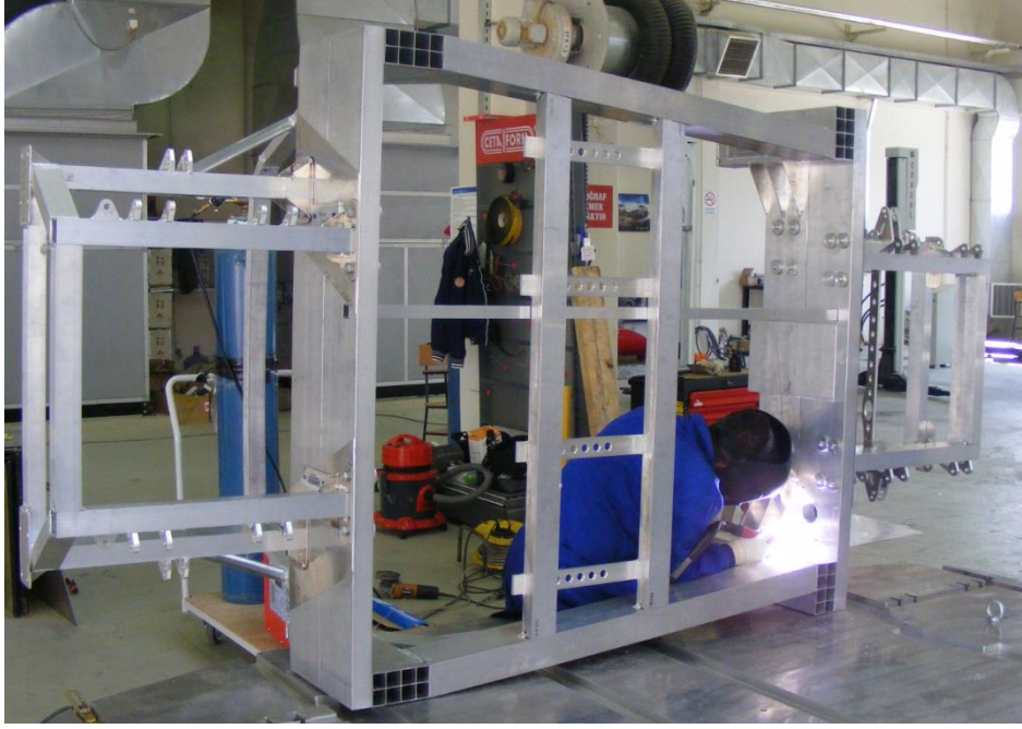
Şekil 5.24 Ana Taşıyıcı Yapının Son İşlemleri
