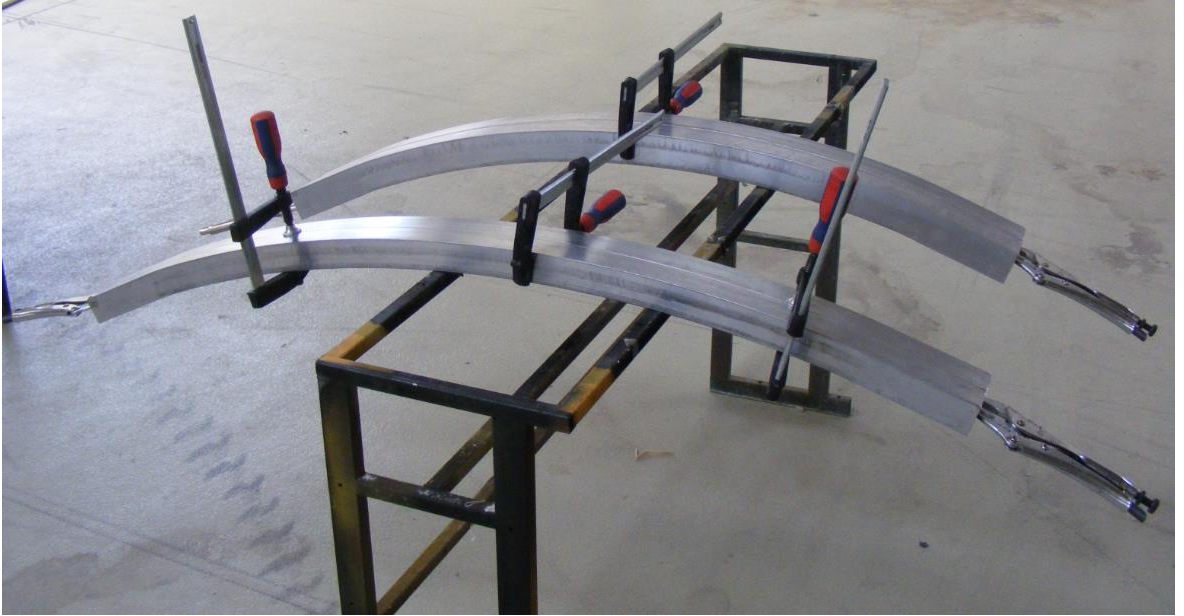
Şekil 5.11 Tampon Profillerinin Yapıştırılması
