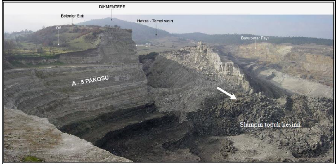
Şekil 10. Gümüşpınar'da 2006 sonunda meydana gelen şev kayması [12]
