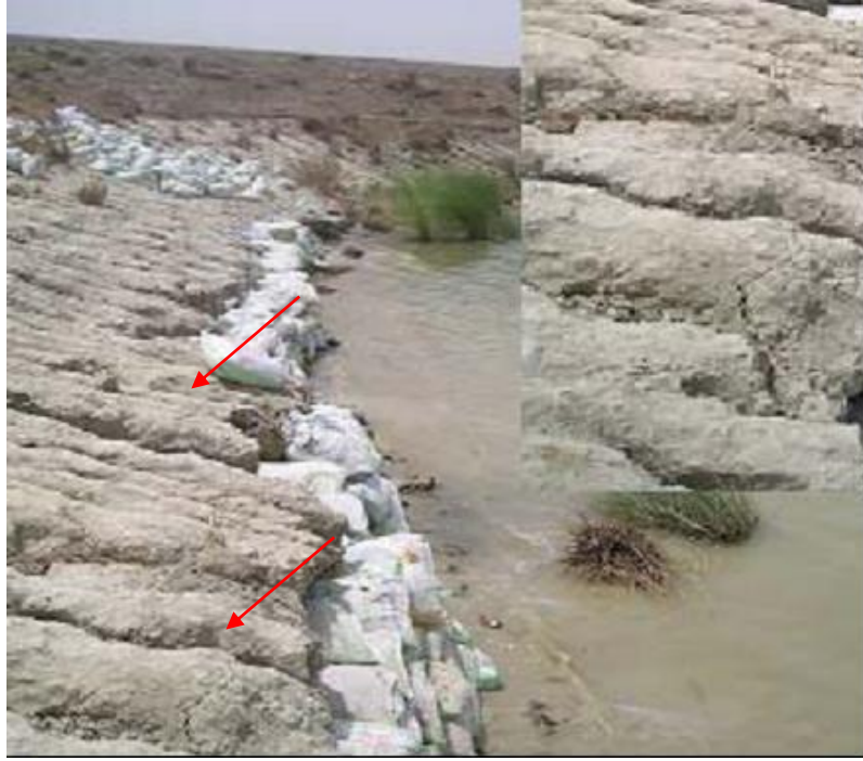
Şekil 2.4. Dispersif killerden kaynaklanan erozyon duraysızlığı [27].
