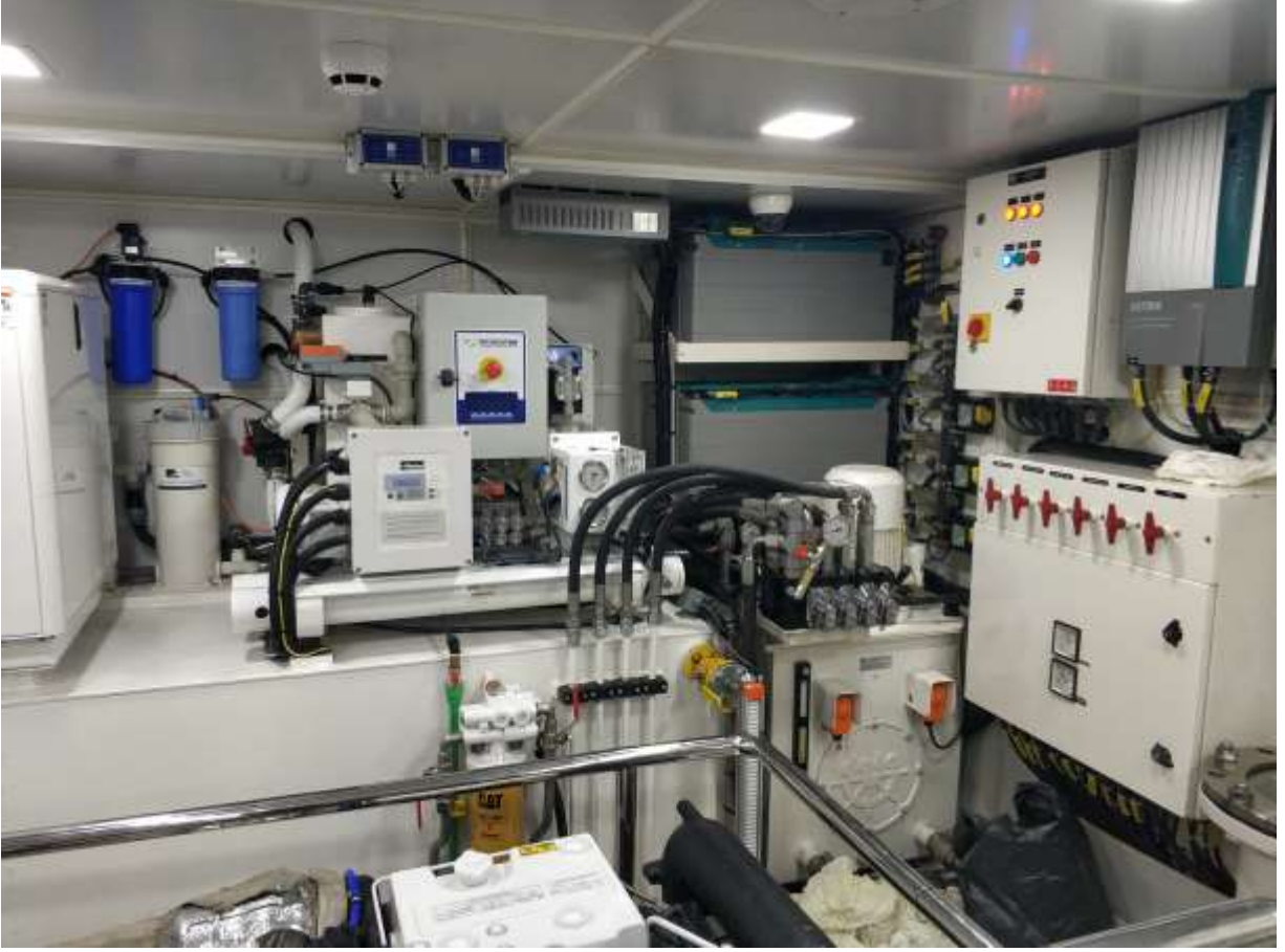
Şekil 2.46. 25 metre Delaware Rock II süperyatının makine dairesi bölümü
