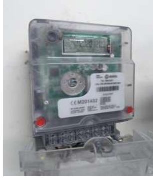
Şekil 3.3. Trifaze elektrik sayacı
