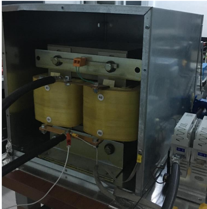
Şekil 50. Davlumbaz içerisindeki bobin görüntüsü.
