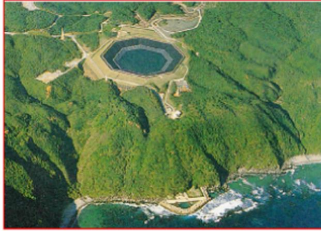
Şekil 5. Okinawa’da kurulan 30MW gücündeki baraj tipi depolama sistemi.
