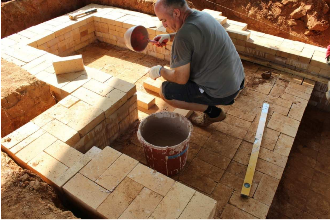
Resim 22: Bacanın ve üçüncü pişirim odasının zemini ile duvarları. Wanju, G .Kore
