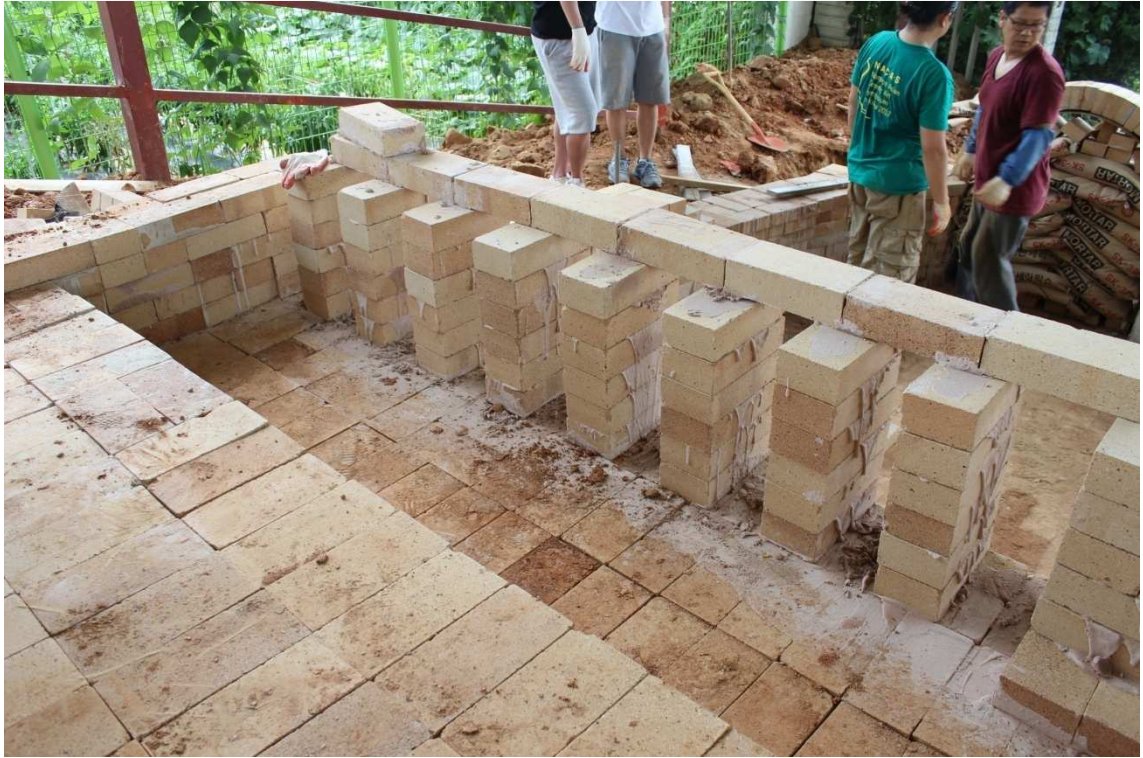
Resim 21: Pişirim odası içi. En sağda ateş geçitleri ve pişirim sırasında odun atılan iç külhan. Wanju, G. Kore
