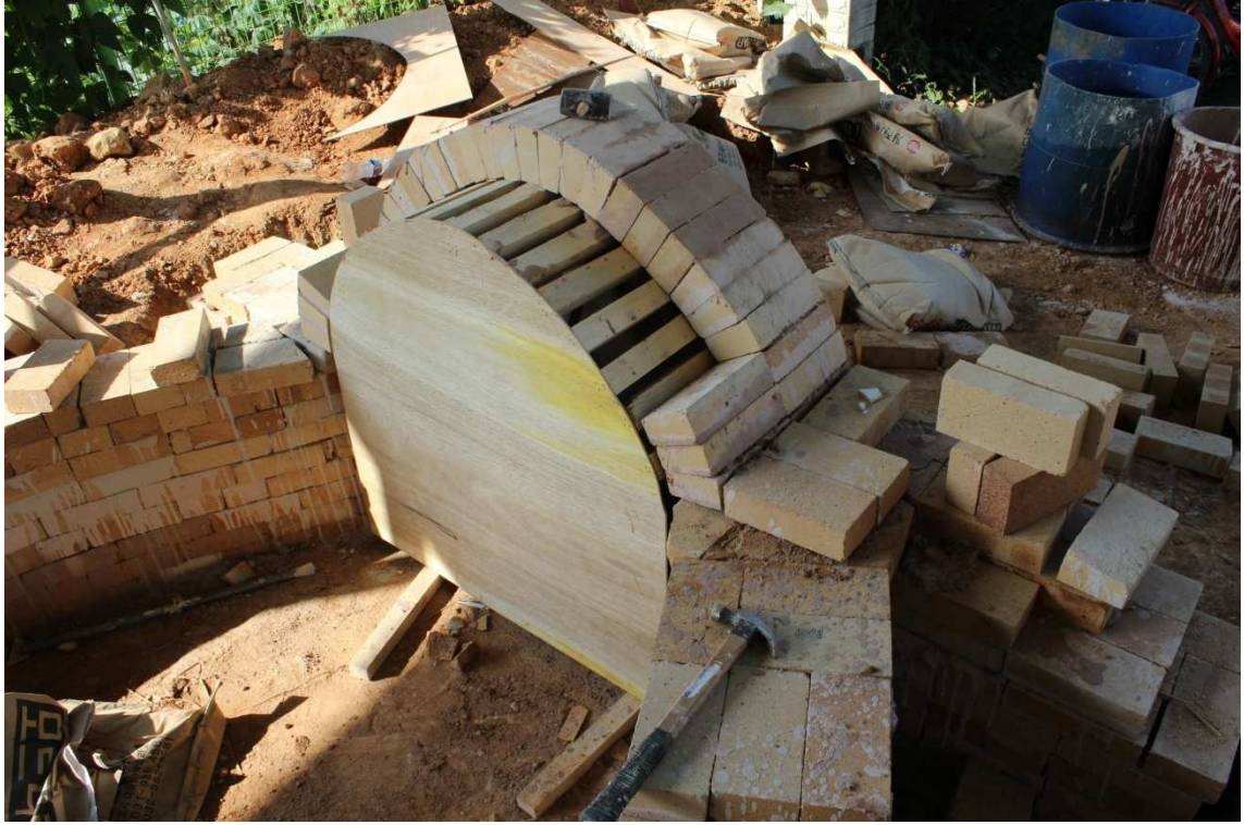
Resim 23: Şablon yardımıyla örülen kemer. Wanju, G. Kore.
