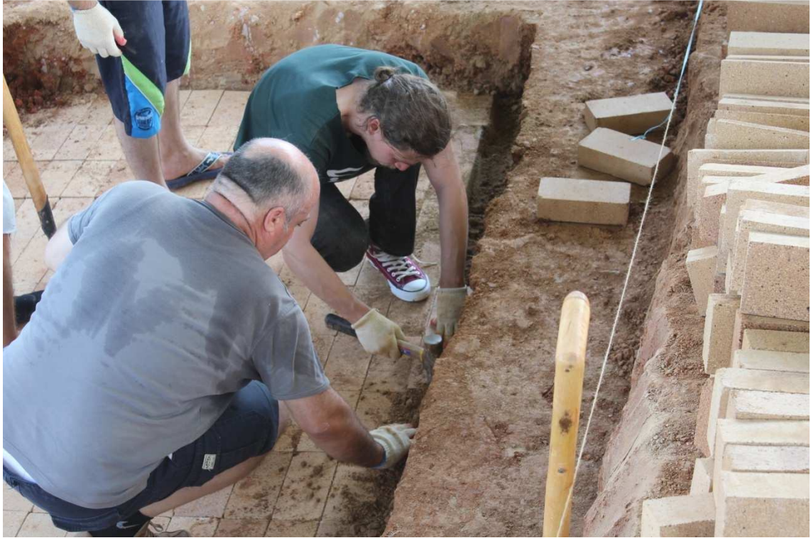
Resim 18: Hüseyin Özçelik, Kerem Sarıkaya külhan zeminini tuğla ile kaplarken. Wanju, G. Kore.
