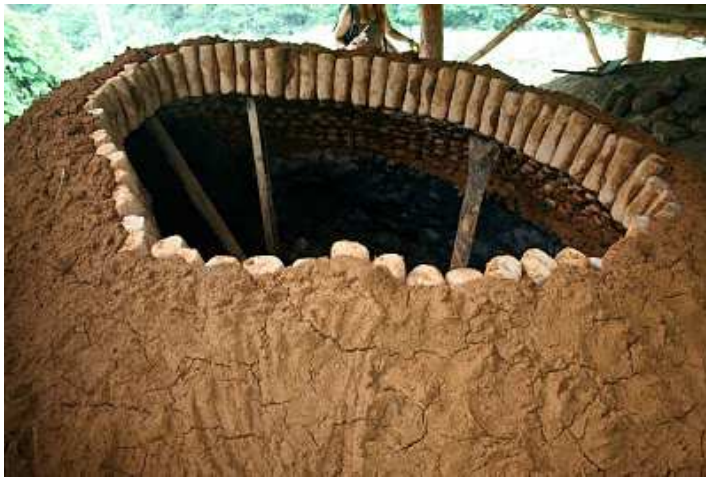
Resim 13: Mangdaengi kullanılarak inşa edilen kubbe.
