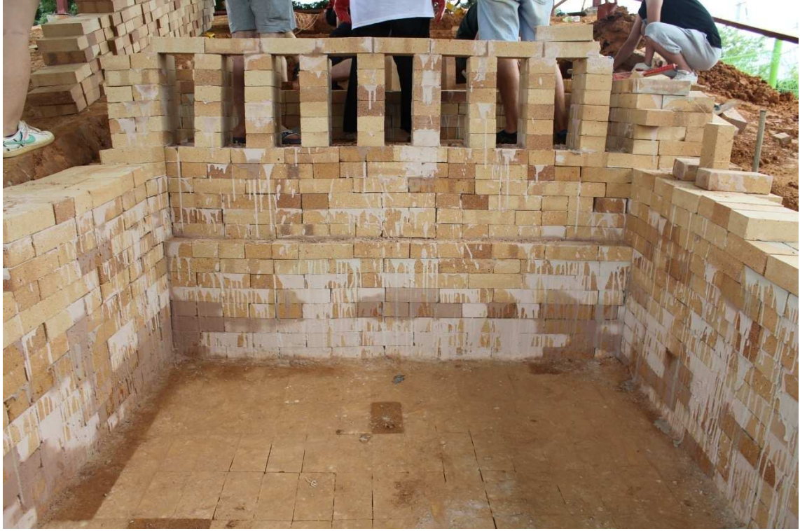
Resim 20: Külhan dip duvarı ve üzerinde ateş geçitleri. Wanju, G.Kore.
