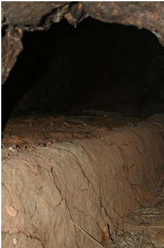
Resim 14: Pişirim odasının içi, alçaktaki basamak iç külhandır.
