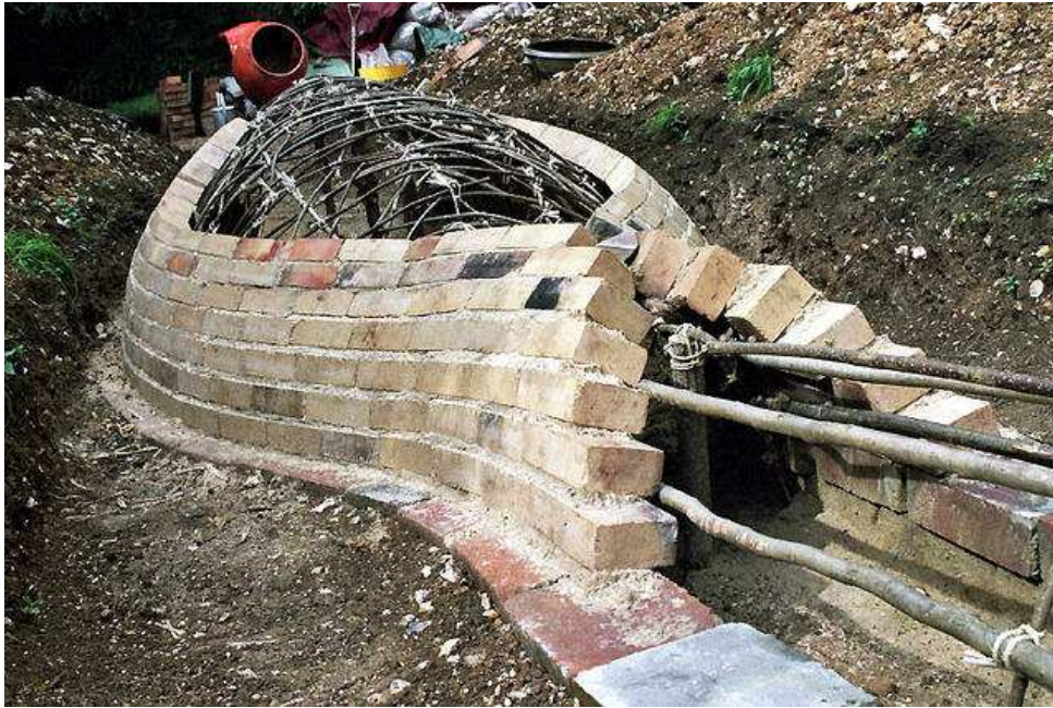
Resim 11: Yapım aşamasında bir anagama fırını.
