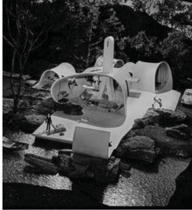
Görsel 2.3. John Johanson'un "Sprayed Concrete House", fotoğraf; Mimar Robert Damora (URL-10)
