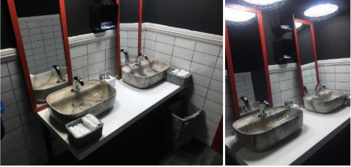
Görsel 203: ‘Hacı Steakhouse’ restoranında çalışmaların son hali
