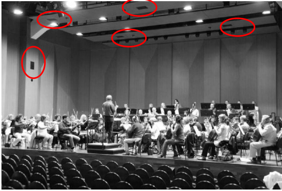
Görsel 110. Sahne üstü ve yan duvarları aktif hücre yerleşimi (Rougier ve Schmich, 2010, s. 3).
