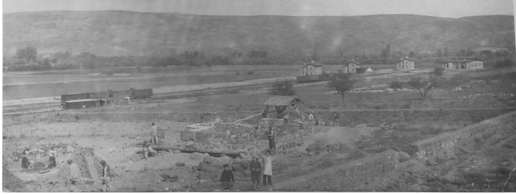
Fotoğraf 60: Çankırı İstasyonu Yapım Çalışmaları 710
