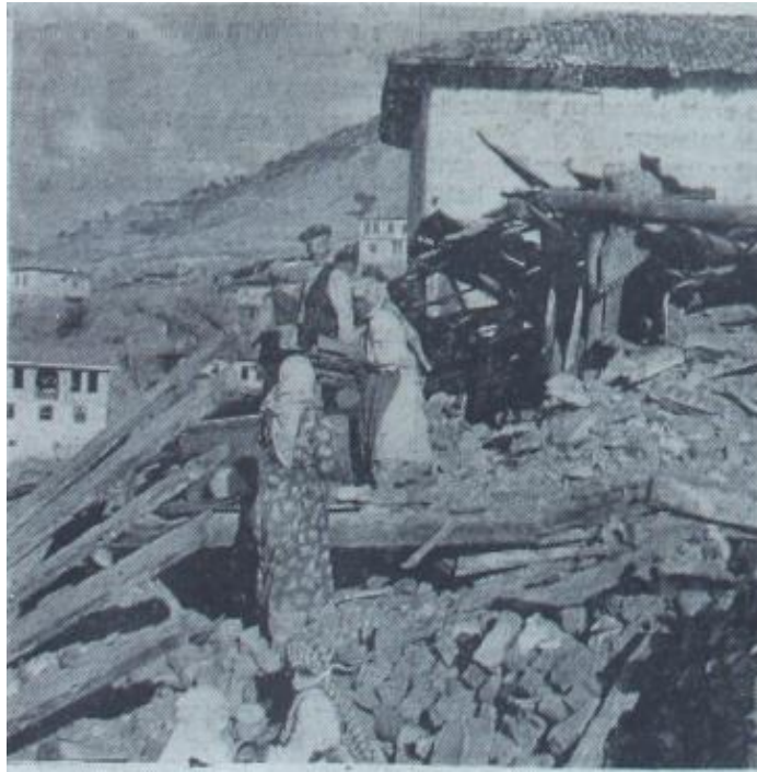
Fotoğraf 78: 17 Ağustos 1951'de Gerçekleşen Çankırı Depreminde Yıkılan Bir Ev 814
