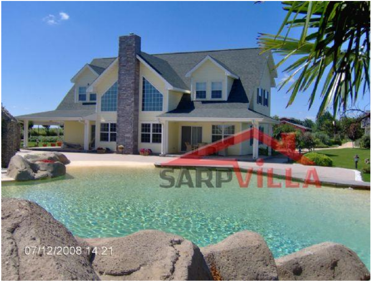
Fotoğraf 5.1 – OSB3 üzerine çatı ve cephe uygulamaları ( foto: Ferhat ÇAKMAK )
