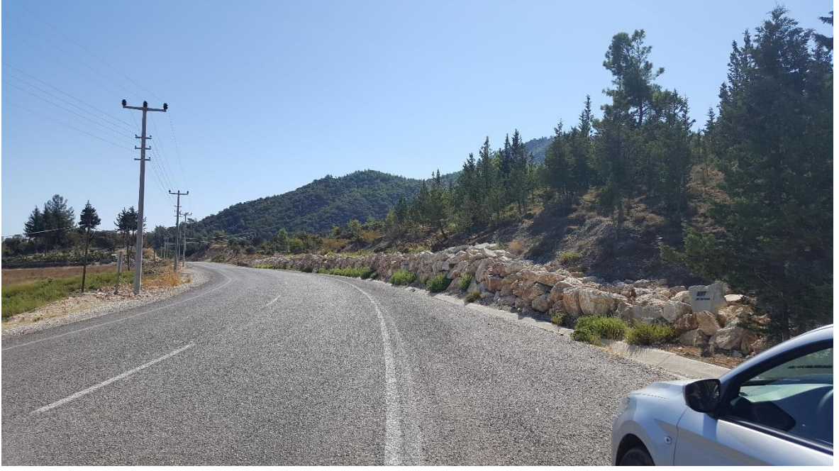
Şekil 3.4. Adrasan ve çevresinde heyelan etkileri için alınan önleme ait örnek fotoğraf
