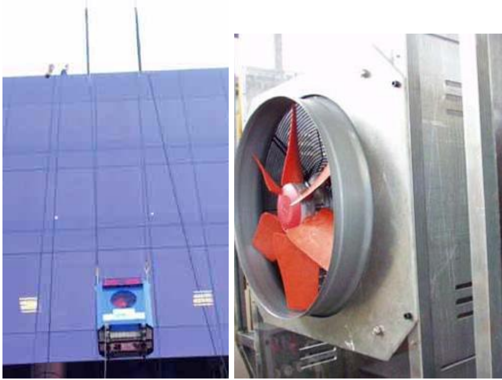
Şekil 2.23 TITO(solda) ve TITO'da kullanılan endüstriyel fan
