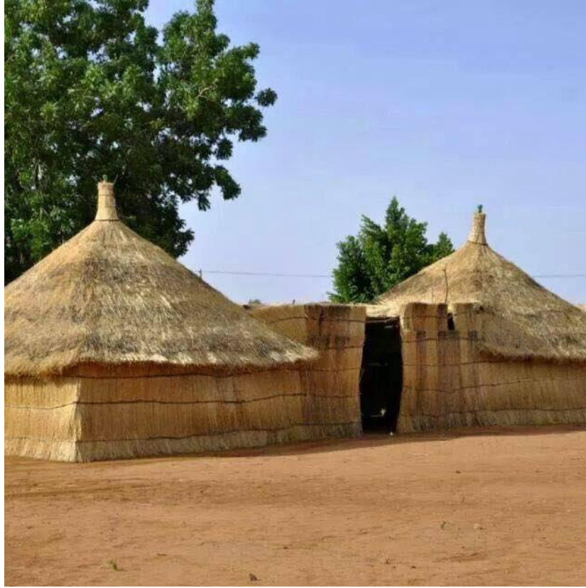
Fotoğraf 1. Saman ve ahşaptan yapılmış doğu ve Batı Sudan'da kırsal ev tarzı
