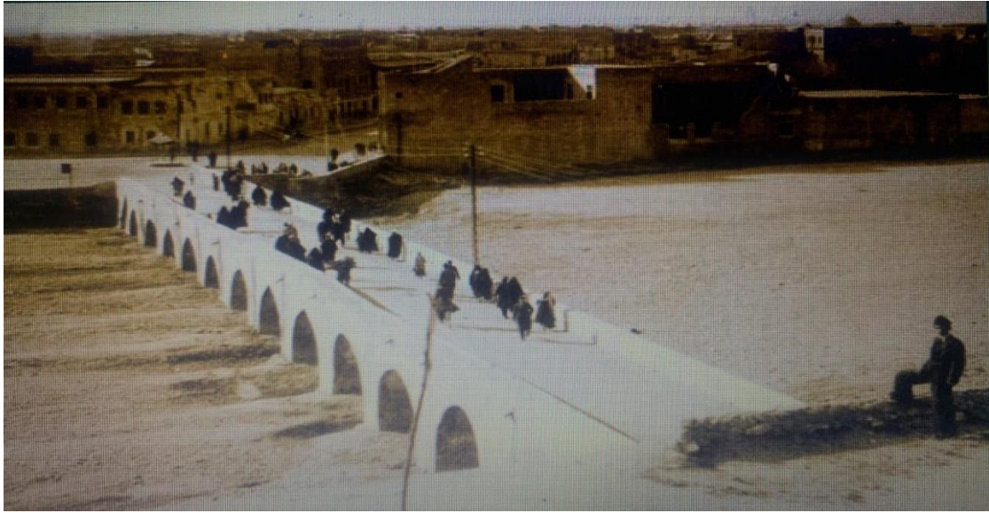
Şekil (5) Kerkük Taş Köprü
