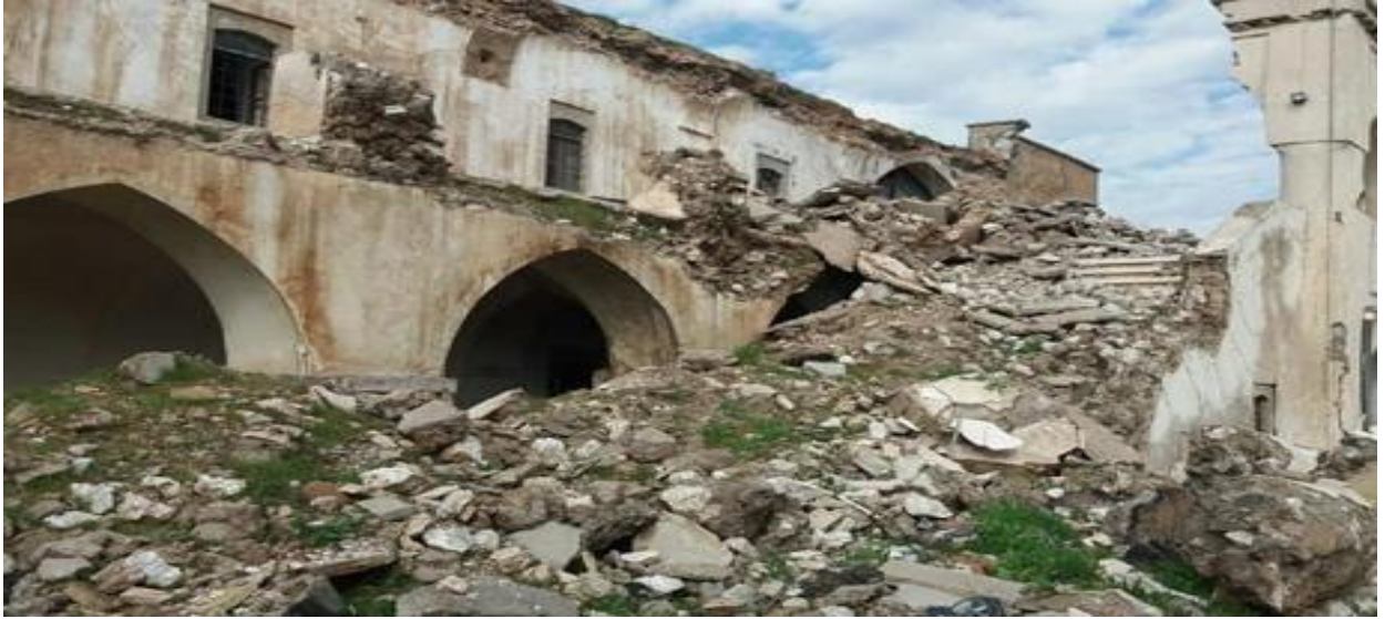
Şekil ( 2 ) Kerkük Kalesi Yıkımdan Sonra
