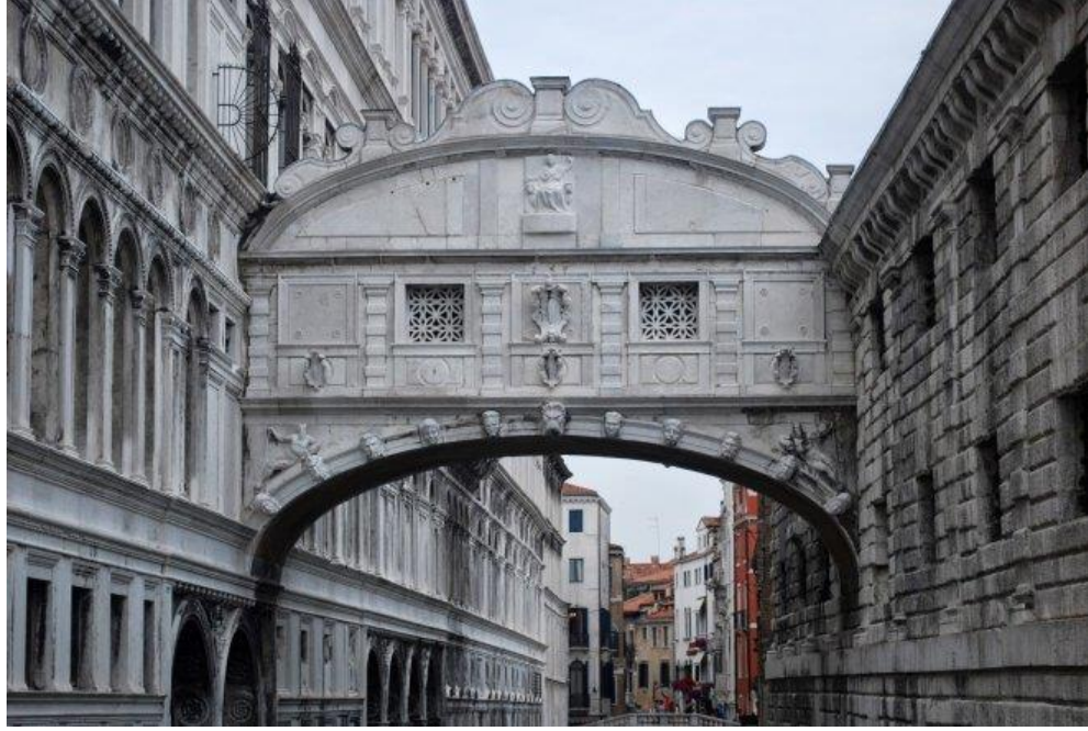
Resim 39: İç Çekişler (Ahlar Köprüsü) Görünümü
