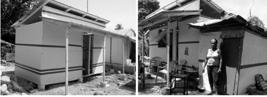
Görsel 33. (Sol) Geçici konutun kullanılmadan önceki hali, (Sağ) Afetzedenin ekleme yaptığı hali (Felix vd., 2013).
