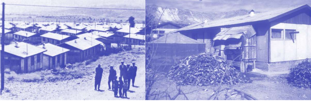
Görsel 35. (Sol) Türk Hükümeti tarafından yapılan prefabrik konutlar, (Sağ) En solda OXFAM poliüretan konut, en sağda prefabrik konut, ortada sonradan eklenmiş yapı (Davis, 2015).
