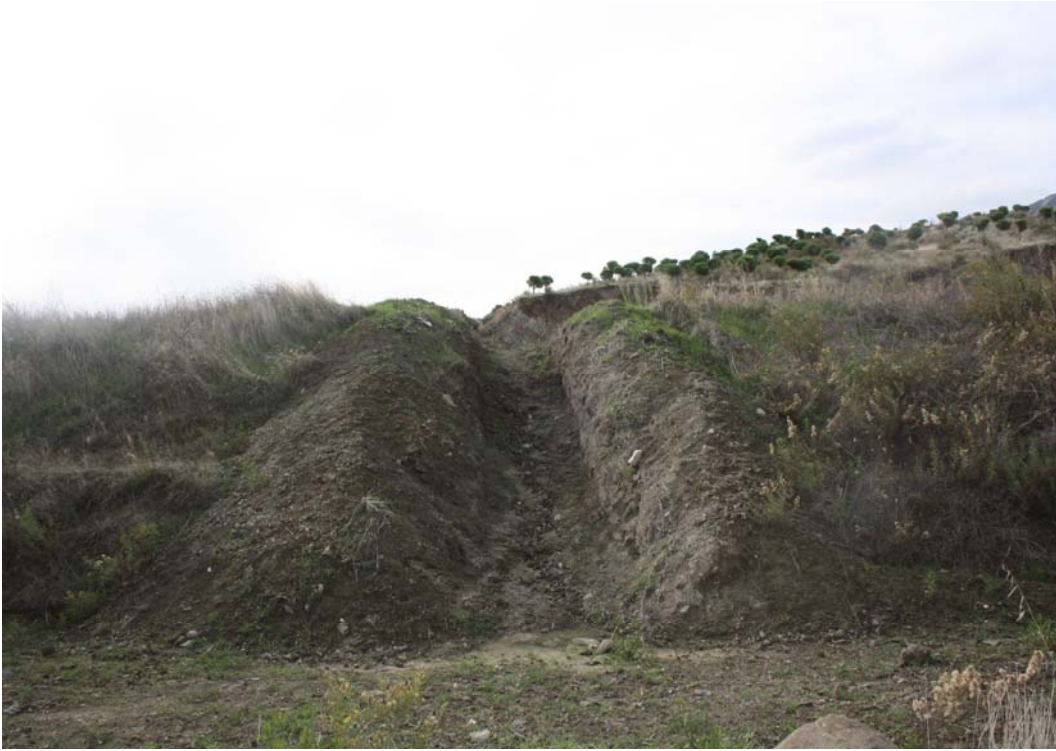
Resim 22: M. Duyuler, Yarılmış Rampa (4 ay sonraki durumu) 2012
